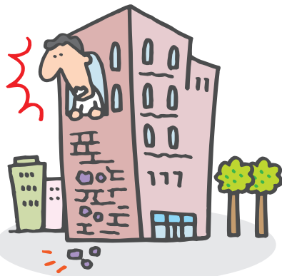
施工ミスにより、タイルがはがれ落ちた
