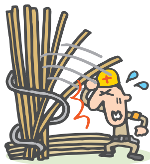
立て掛けてあった資材が崩れ落ちてきて下敷きになった。
